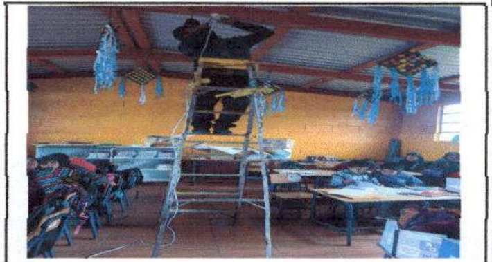
Foto 4: Reinstalando y cambiando plafoneras, focos de la energía eléctrica dentro de las aulas.
