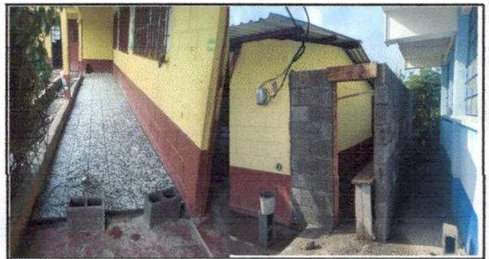
Foto 6: Pegando el piso granito en el corredor de la escuela y ampliando la cocina escolar.
