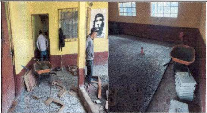
Foto 3: El albañil y sus ayudantes trabajando en la dirección de la escuela colocando el piso cerámico.
