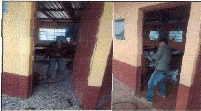
Foto 1. Trabajando para cambiar las chapas de las puertas de cuatro aulas
